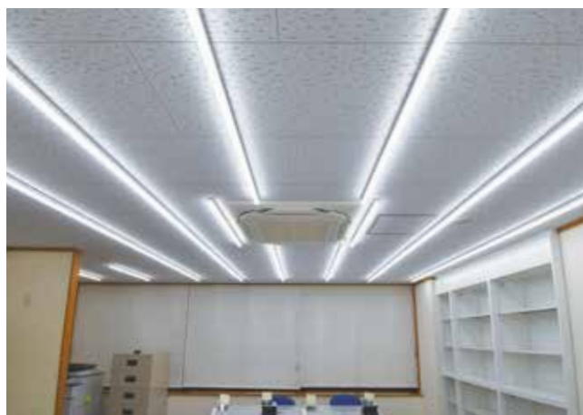
ベース照明全てを同じ照明器具で統一
